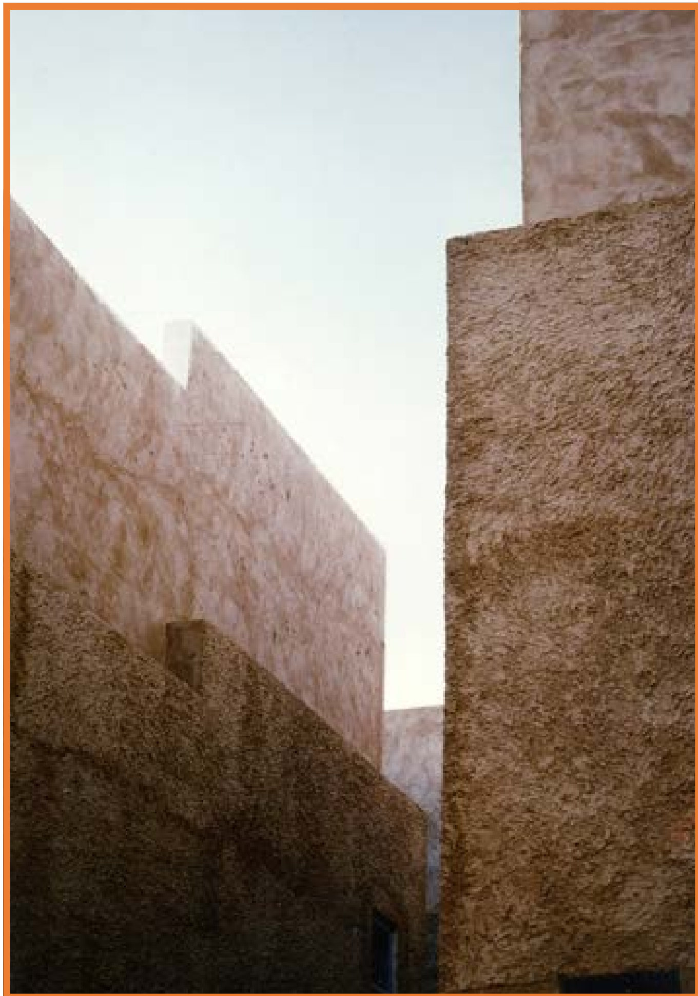
Logements Sidi Abbaz Mzab Algérie, André Ravéreau Manuelle Roche ADAGP 1976
