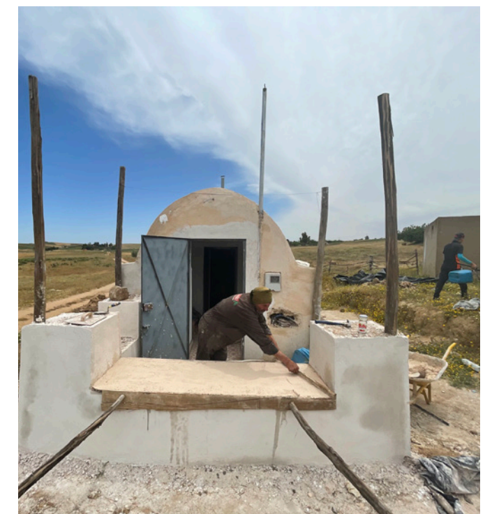
Application d'enduits à la chaux sableuse, Photo par A&D
