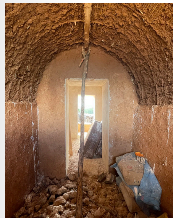
Application d'une couche de terre pailleuse, Photo par A&D
