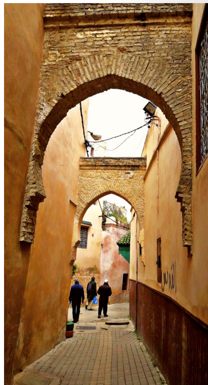
Meknes, ruelles dans la medina murs en pise et brique
