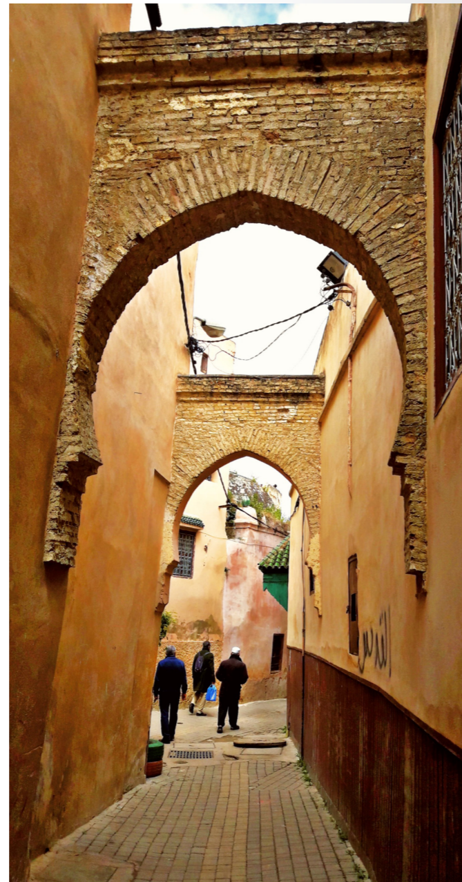
Meknes, ruelles dans la medina murs en pise et brique
